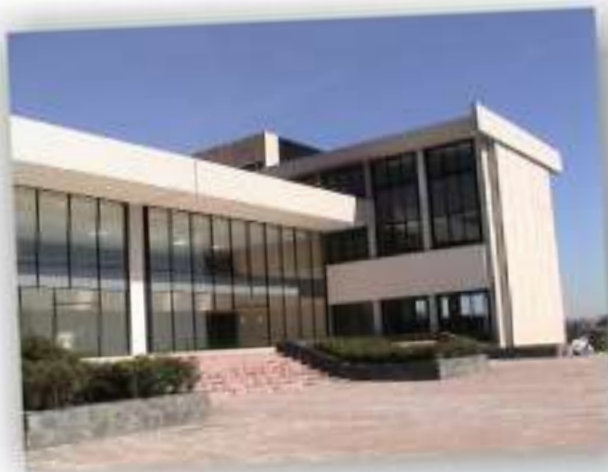
Un nuevo instituto de Bachillerato
